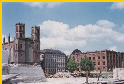
Ansicht des Friedrichswerder mit Friedrichswerderscher Kirche, Bauakademie und umliegender Bebauung um 1955 (Vor Sanierung) Foto: Lothar Brauner
