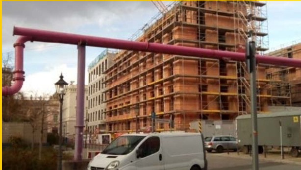
Östliche Baustelle an der Friedrichswerderschen Kirche Foto: Anne Schäfer-Junker
